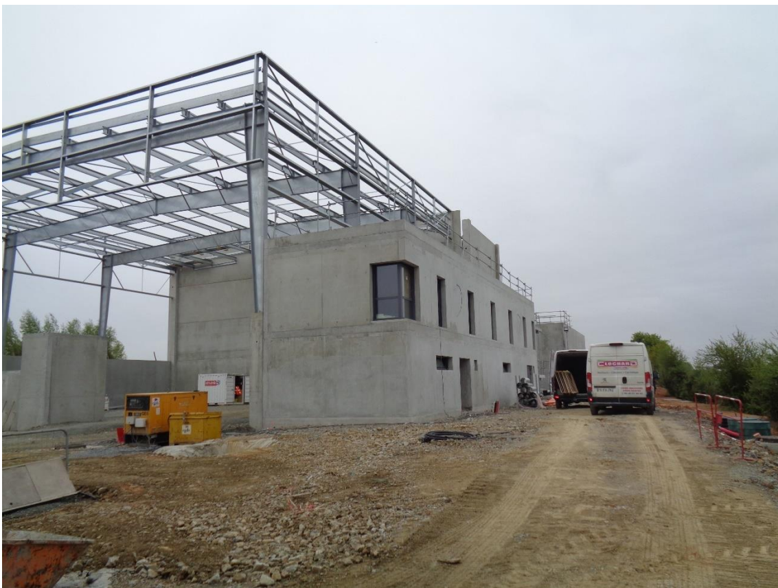
Photographies du bâtiment en cours de construction (avril 2023)
