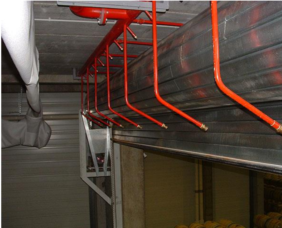
Exemple de têtes formant un rideau d'eau
