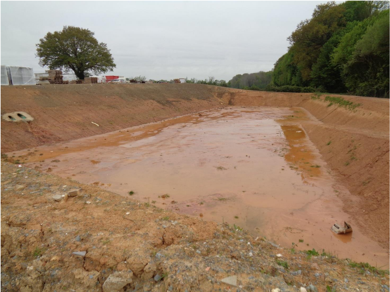
Photographie du bassin en cours d'aménagement (avant étanchéification)
